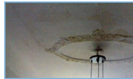
Abb. links: Wohnzimmerdecke im 4. OG mit Feuchtigkeiterscheinungen
